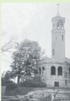
Uszkodzona Wieża Braniborska ze śladami po pociskach
