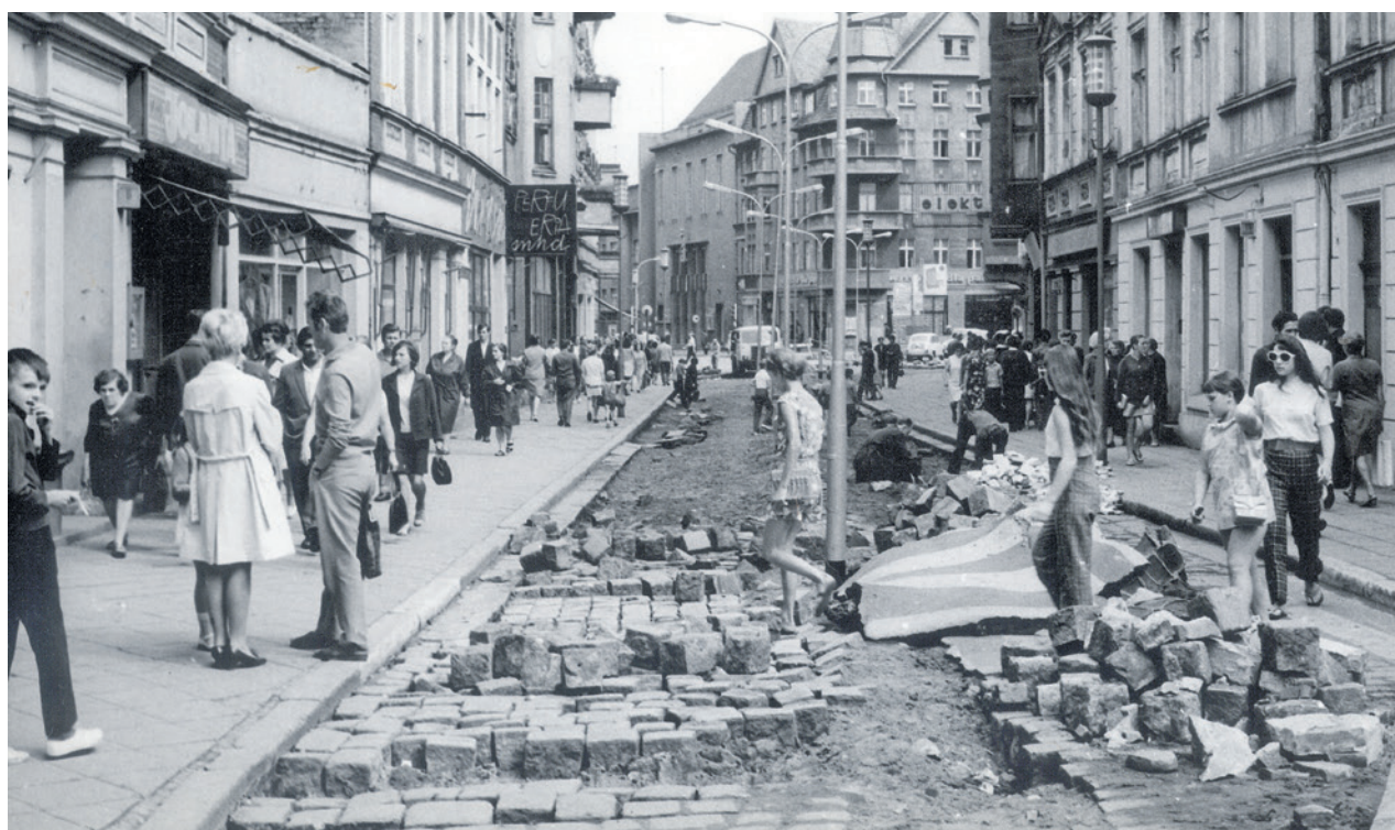
Sierpień 1970 r. Trwa rozbiórka bruku na ul. Żeromskiego.
