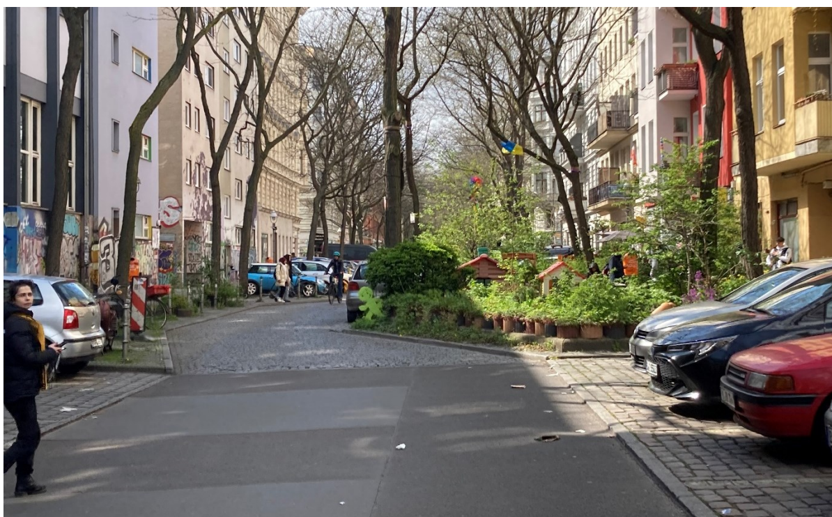
Zdjęcie 7. Berlin, Böckhstraße – zwężenie jezdni (szykana) wykorzystane do budowy skweru
